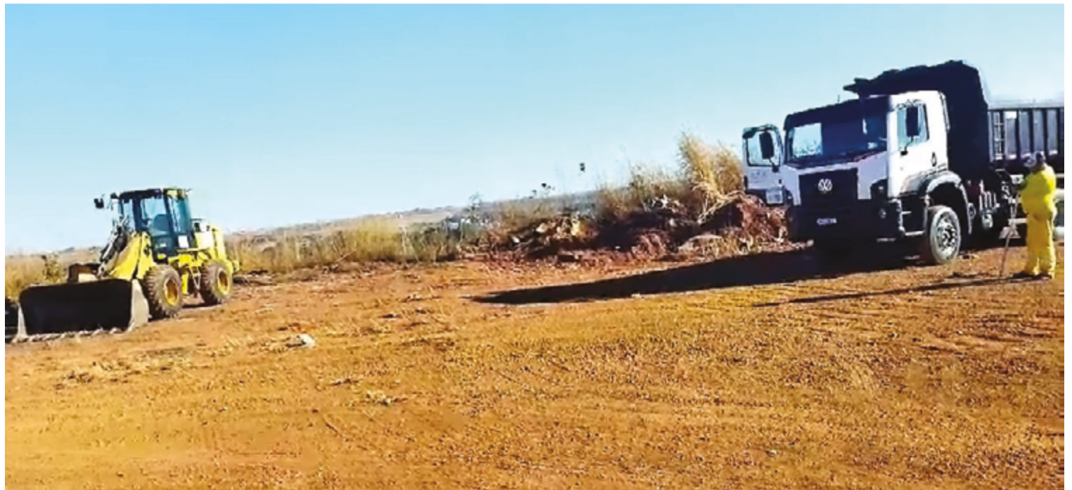
Construtora responsável pela obra iniciou nesta quarta-feira, 3, à montagem da estrutura que dá suporte aos trabalhos
